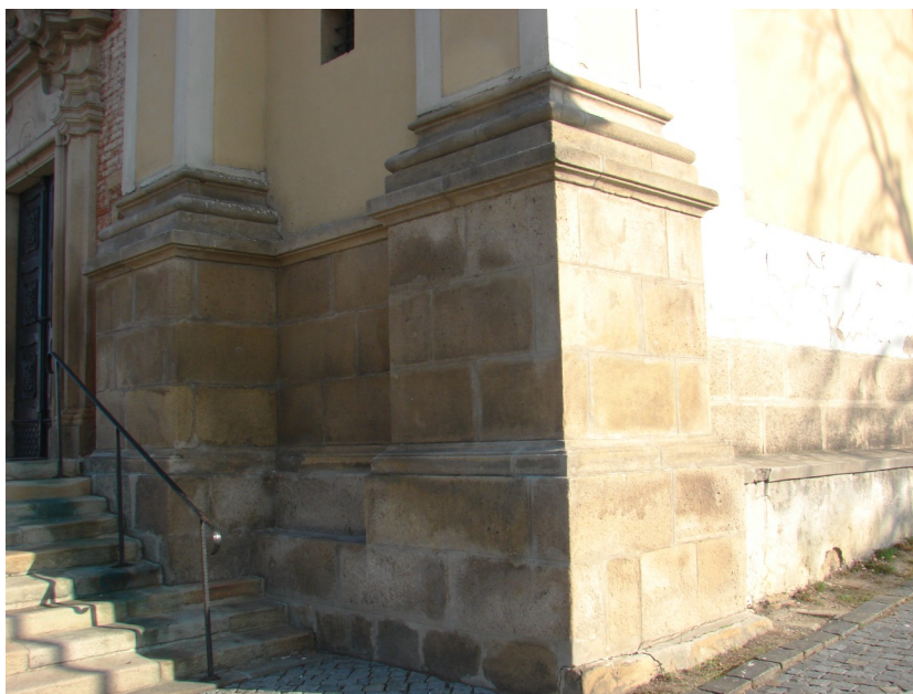
Pískovcové obložení jihozápadního nároží kostela, včetně ukončení soklů a profilovaných patek pilastrů.
