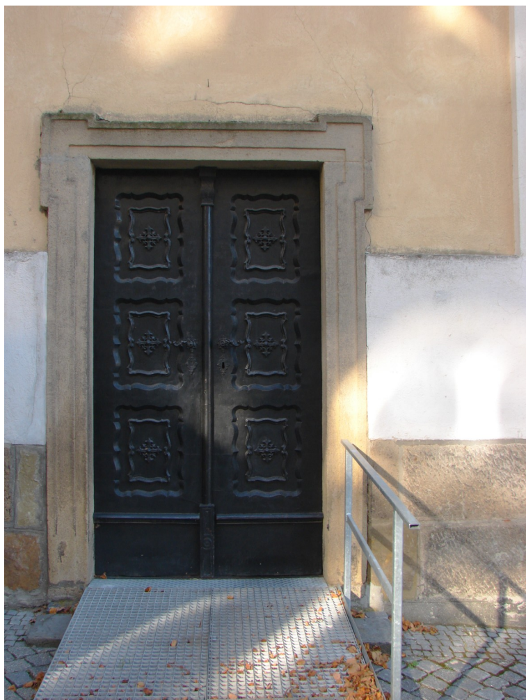
Pískovcové ostění bočního vstupu do budovy kostela ze severní strany.
