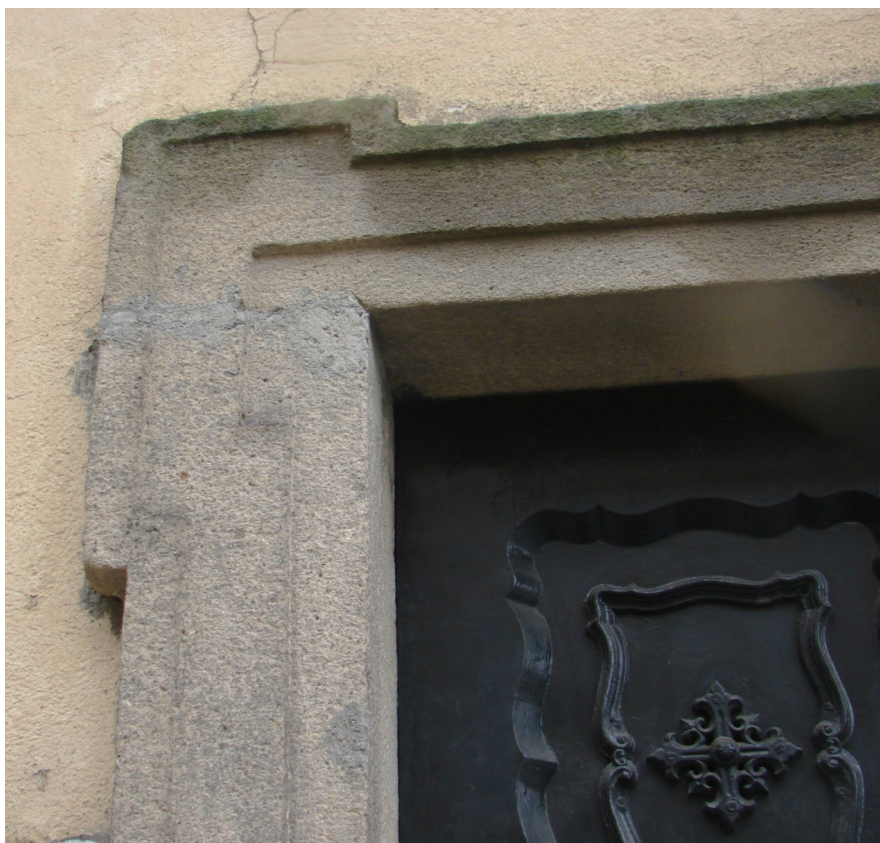
Detail spoje bloku horní a svislé části ostění se zvětralými doplňky, levá strana, vstup do kostela ze severní strany.
