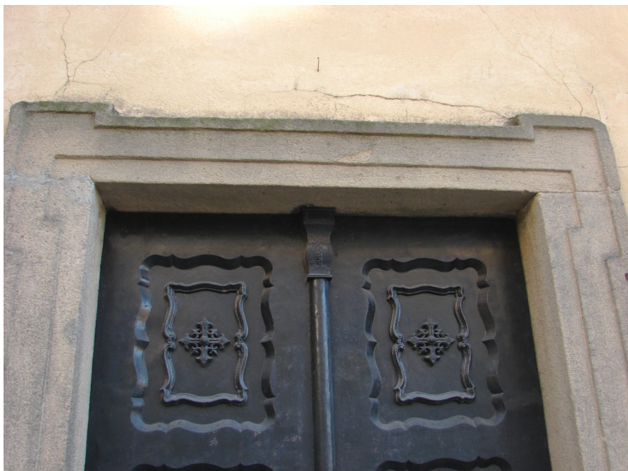
Detail horní části pískovcového ostění bočního vstupu do kostela ze severní strany.
