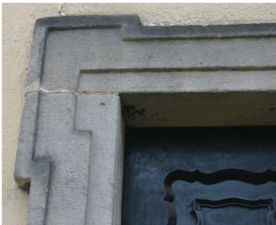
Detail spoje v horní části ostění, levá strana, boční vstup do budovy z jižní strany.
