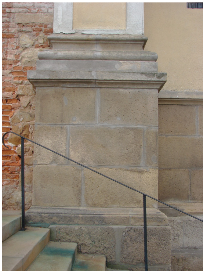
Detail vnitřní části obložení, ukončení soklu a patky pilastru na pravé straně od hlavního vstupu do budovy kostela.
