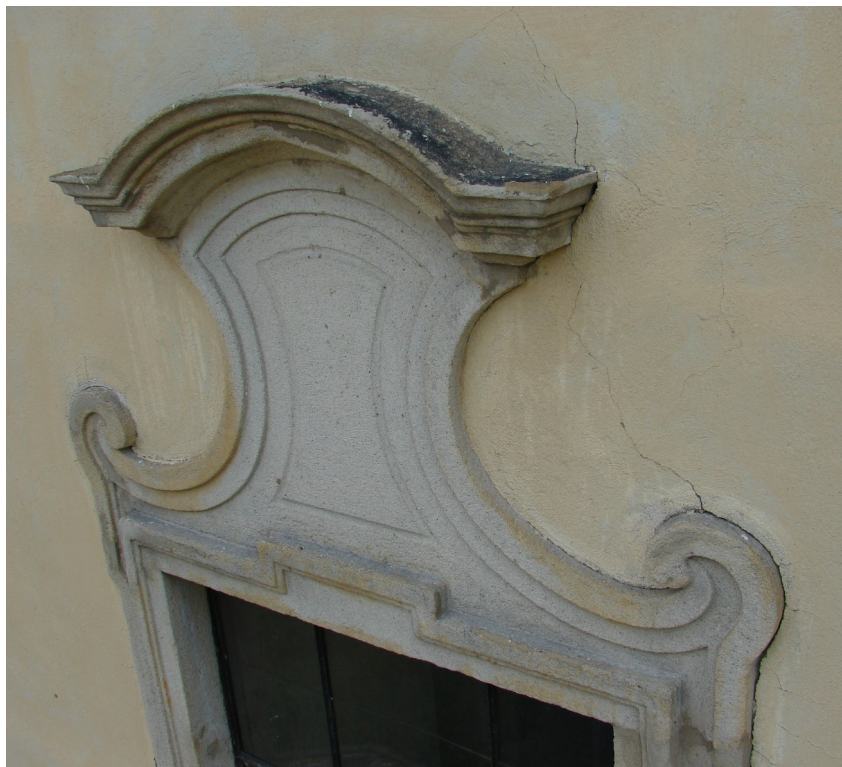
Detail horní části ostění okna s výrazným znečištěním na římse.
