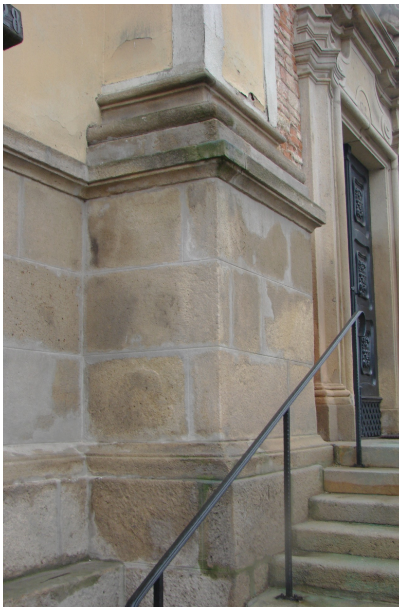
Detail vnitřní části obložení, na levé straně od hlavního vstupu do kostela včetně ozdobných prvků - ukončení soklu a profilované patky pilastru.
