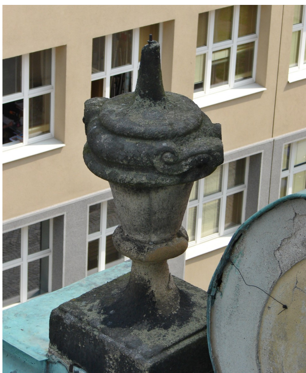
Pískovcová květinová váza na levé straně střechy kostela, s trhlinou ve spodní zúžené části.
