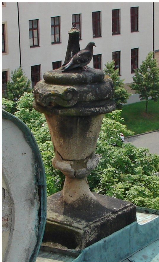
Pískovcová květinová váza na pravé straně střechy kostela, s výrazným defektem ve spodní části.
