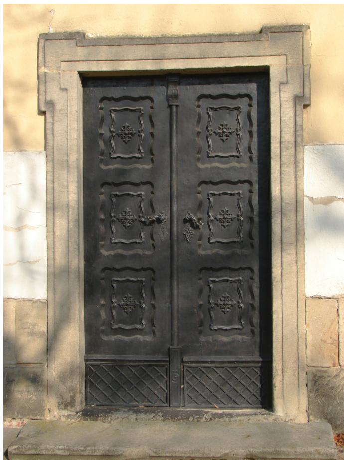
Pískovcové ostění bočního vstupu do budovy, z jižní strany kostela.
