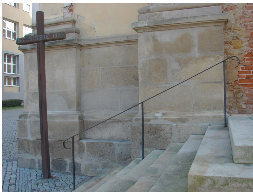
Pískovcové obložení západní strany kostela – levá strana od hlavního vstupu.
