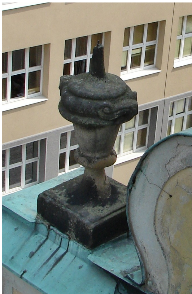
Pískovcová květinová váza na levé straně střechy kostela, s trhlinou ve spodní zúžené části.
