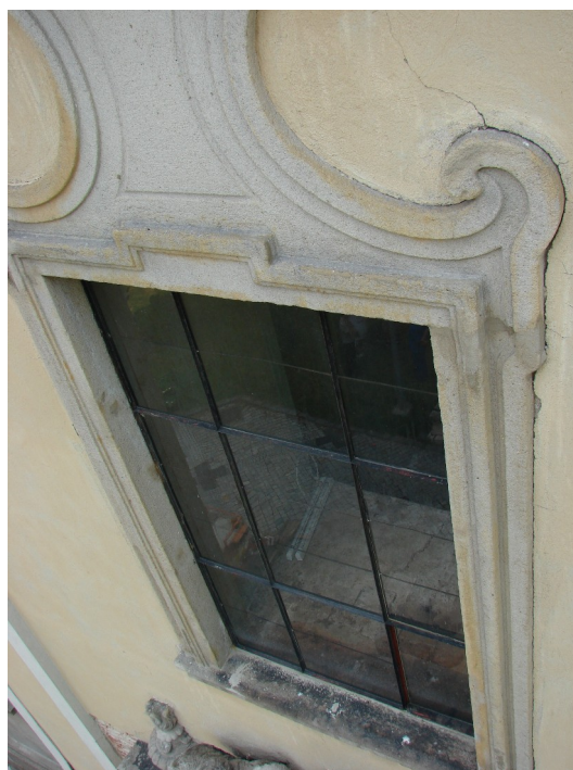
Detail dolní části ostění okna s výrazným znečištěním spodní části a defektem na pravé straně.
