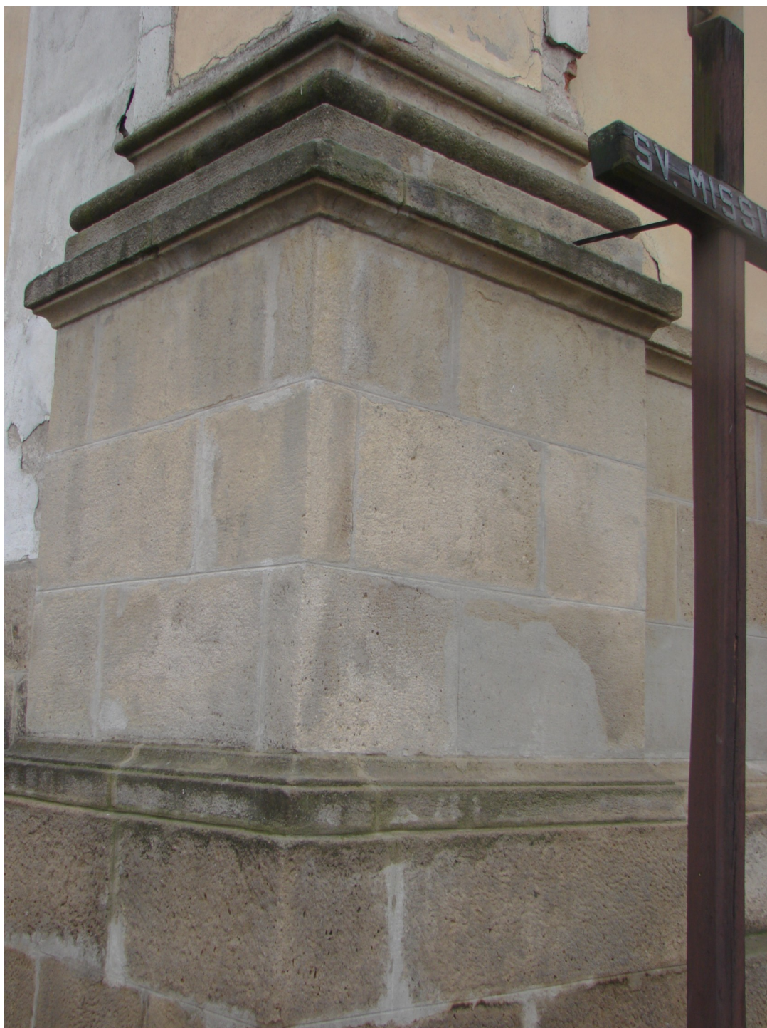
Detail vnější části obložení na levé straně od hlavního vstupu do budovy kostela včetně ozdobných prvků – ukončení soklu a profilované patky pilastru. Severozápadní rohová část.
