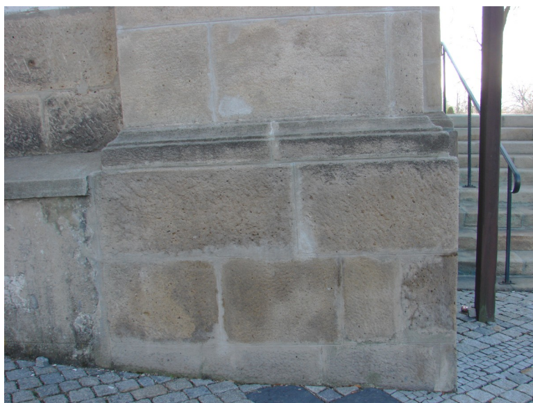
Detail spodní části pískovcového obložení severní strany kostela – nároží.
