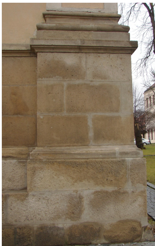
Detail vnější části obložení, ukončení soklu a patky pilastru na pravé straně hlavního vstupu do budovy kostela.
