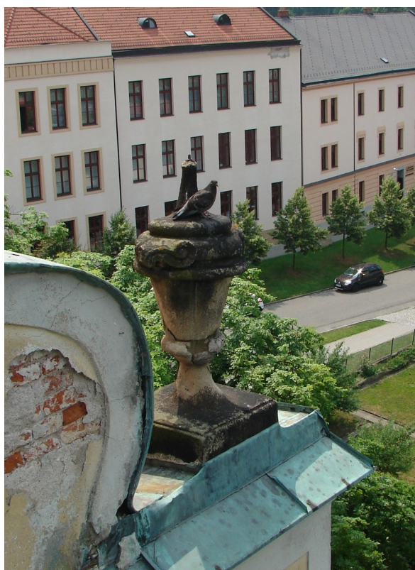
Pískovcová květinová váza na pravé straně střechy kostela, s výrazným defektem ve spodní části.
